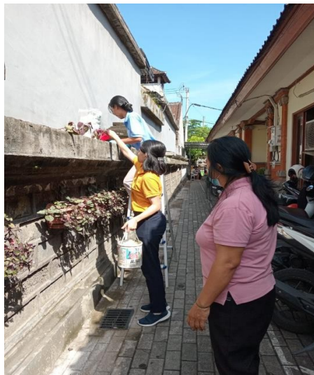
Gambar 1. Pembersihan Areal Atas Tembok
