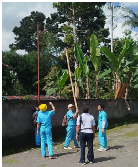
Gambar 10. Kegiatan Pemasangan Lampu Penerangan
