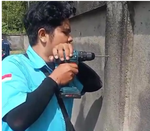
Gambar 8. Proses Pengeboran Tembok Tempat Pemasangan Tiang Lampu
